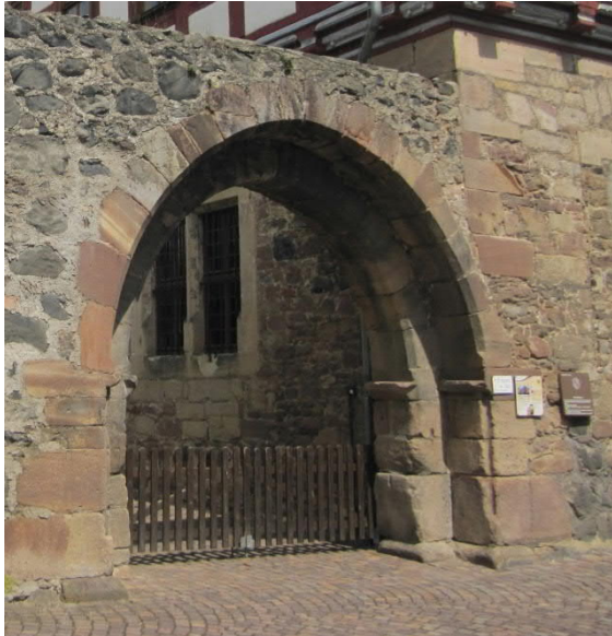
Abb. 3: Rundbogen am Hochzeitshaus in Fritzlär, eig. Aufnahme
