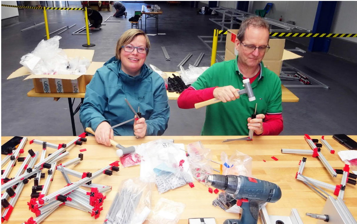
Abb. 10: Eifrige Hände (im Bild Gertraud Rust und Thomas Magin) bei der Endmontage der C-Stücke. Im Hintergrund James D. Behra und Alexander Salameh beim Bau des Untergestells der Talstation. Rechts hinter der Absperrung ist die Stützkonstruktion bereits fertig.
