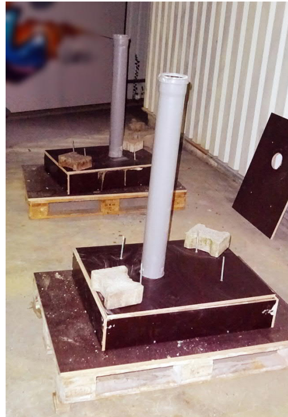
Abb. 9: Fast fertig: Zwei von vier Fundamenten
